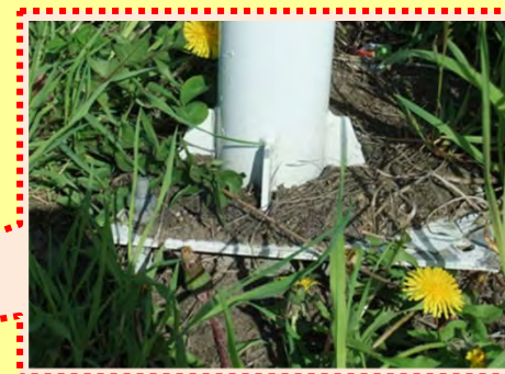
(支柱根元部分の拡大)
