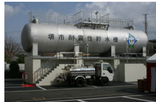
耐震性貯水槽
