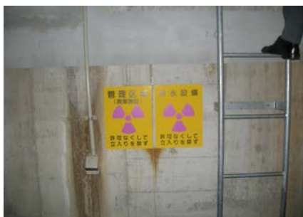
梯子を降下しないと管理区域であることが分からないため、管理区域の標識の設置位置を見直す必要があるもの（●ではなく▲の位置に設置する必要）
