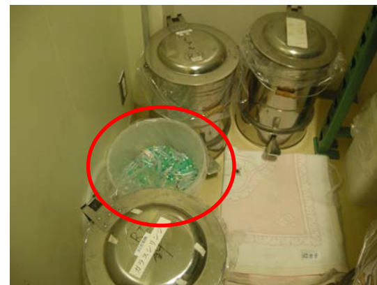
容器が耐火性の構造となっていない。また、容器には蓋がされておらず、気密性が保たれていないもの
