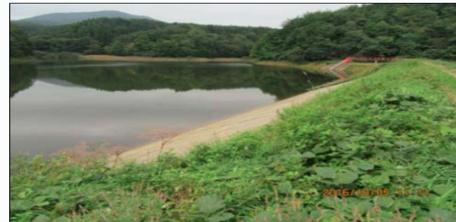
【事例4】進入防止の立て看板が設置されていない(34事例)
