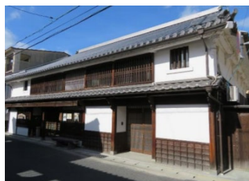
改修対象施設
