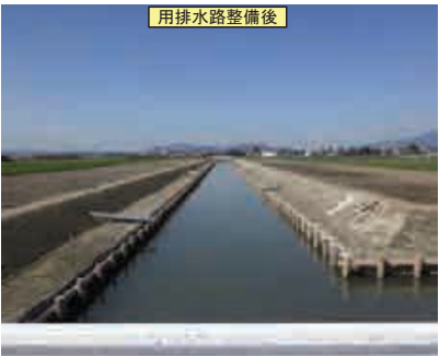
用排水路整備後
