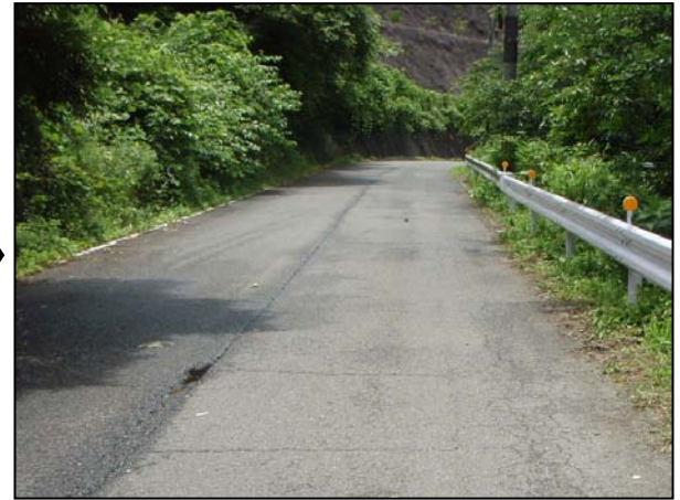
⇩ガードレール設置後
