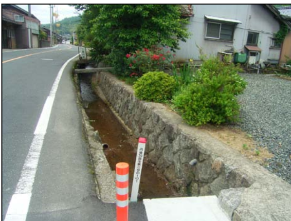
⇩側溝蓋設置前
