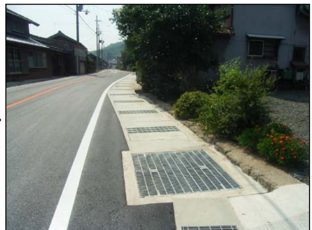
⇩側溝蓋設置後
