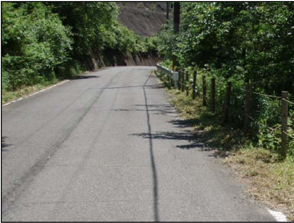
⇩ガードレール設置前
