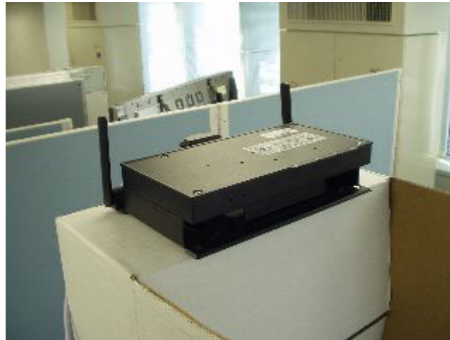
写真 2.15 AP-2500 設置状況(縦)
