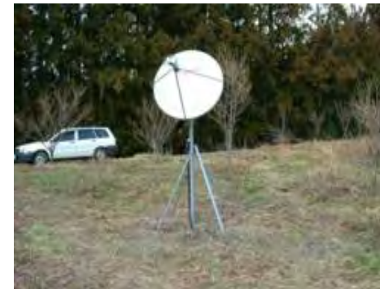
【衛星アンテナ設置】
