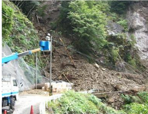
〔切断したケーブルの復旧作業〕
