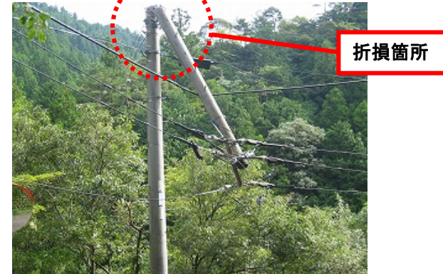
〔電柱の折損〕
