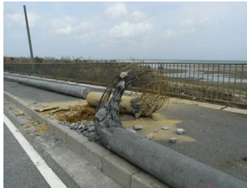
〔電柱の倒壊〕
