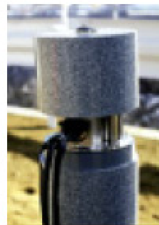
道路わきからひっそりと頭を出さず情報コンセント。
