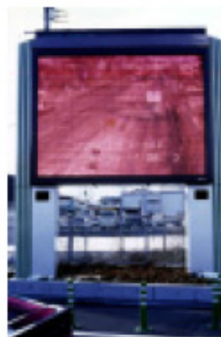
道路情報センターに設置されたモニターの映像も、道路下の光ファイバケーブルから情報を吸い上げている。
