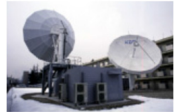
IBC敷地内に設置されたパラボラアンテナ。右側のアンテナがインド洋上の衛星に、左側のアンテナが太平洋上の衛星に向いている。
