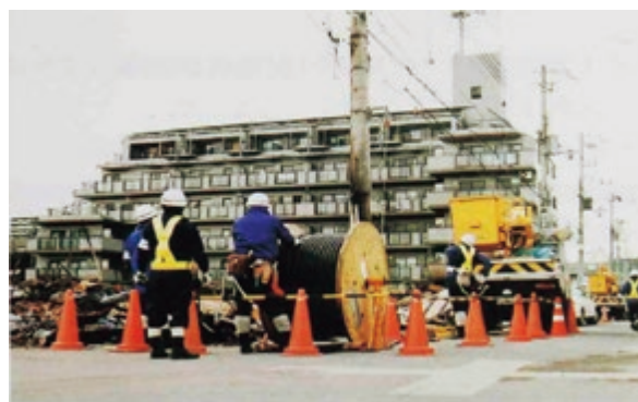
図表2-4-4-2 阪神大震災における固定電話回線の復旧
