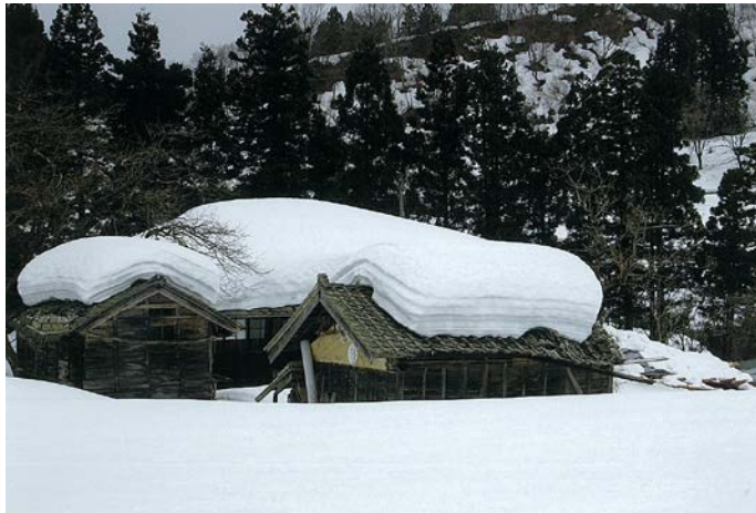
屋根の雪で押しつぶされそうになっている空き家 (B市)
