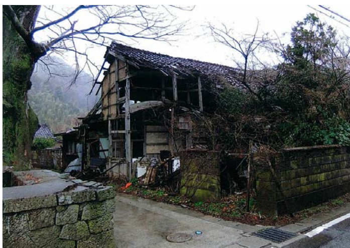
④ 放置されたまま朽ちていく空き家 (D市)
