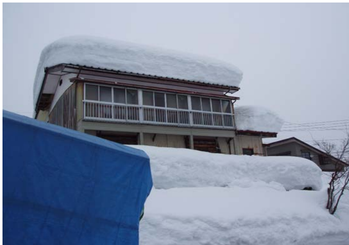
③ 屋根の雪が今にも落ちてきそうな空き家 (C市)
