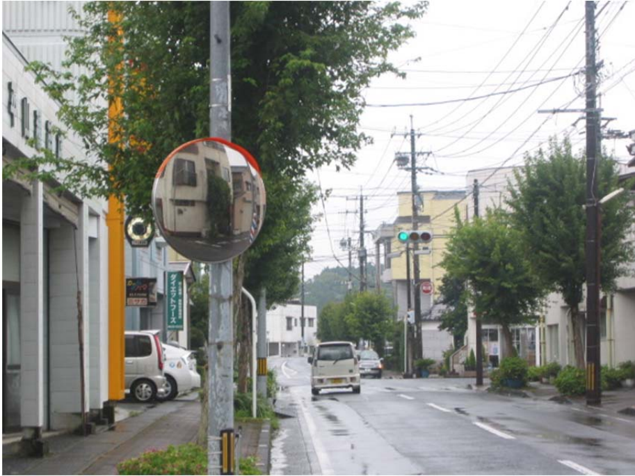
NTTの電柱に設置されたカーブミラー
