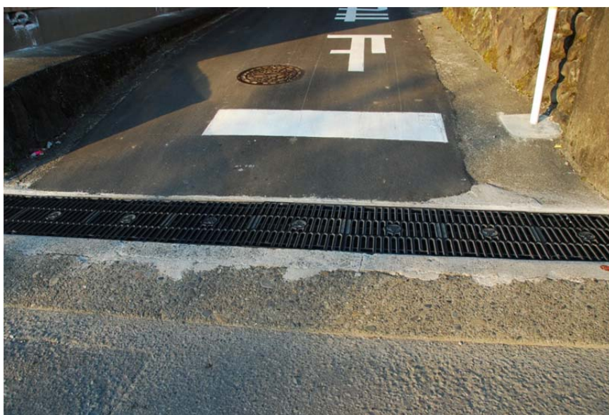
溝蓋（グレーチング）の拡大写真
