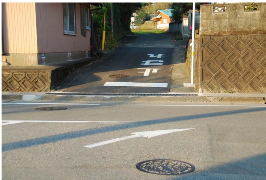
新たに設置された排水用の溝蓋（グレーチング）
