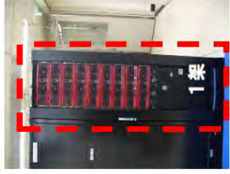
HVDC用 整流装置
