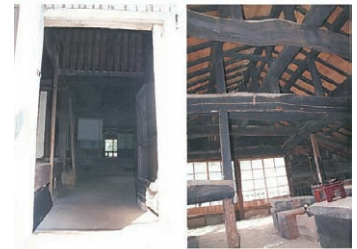
▲木戸から奥の座敷を望む
