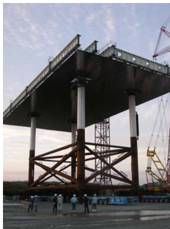
ジャケット栈橋本体
