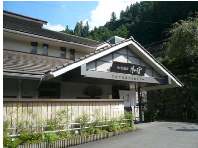
バイオマスボイラー設置の月ヶ谷温泉
