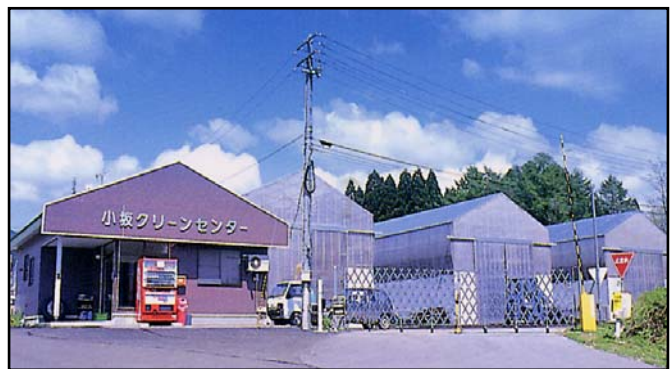
↑ポークランドグループの小坂グリーンセンター (日量 60tの糞尿処理能力)
