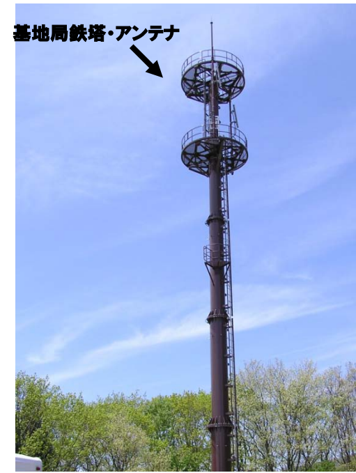
<塗装の工夫を施した一例>
