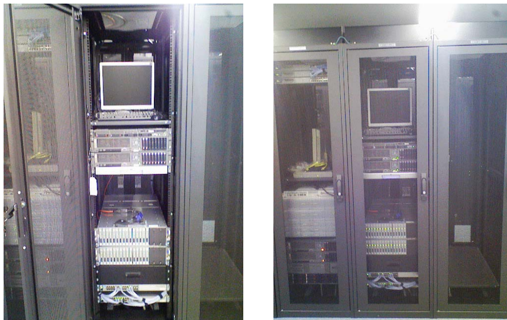
図 2-2-4 テレワークシステム設置拠点風景
