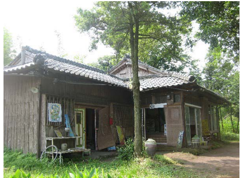
↑ アトリエ6号館
