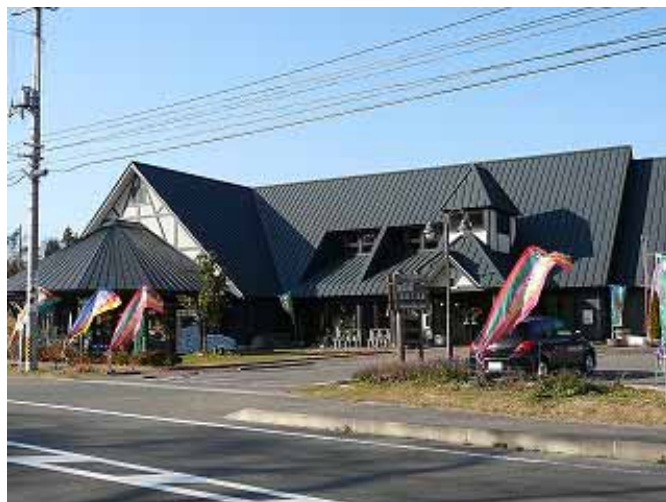
道の駅「ふくしま東和」あぶくま館の外観 12月に行われる「木幡の幡まつり」の旗がたなびいている。
