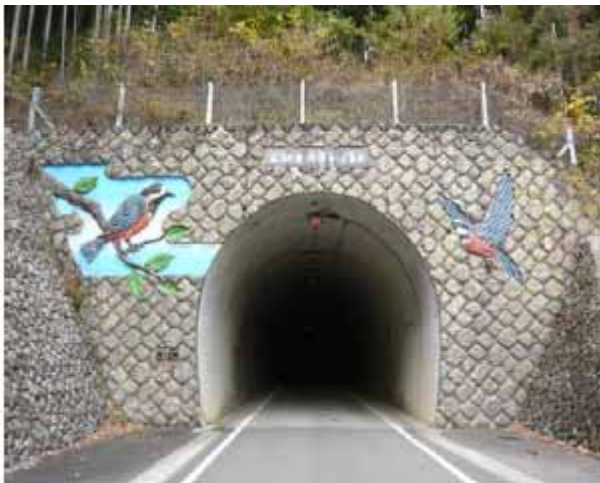
床鍋倉川夢トンネルは2003年に開通した。落成式には集落の面々も集まり、トンネルの完成を皆で祝ったという。
