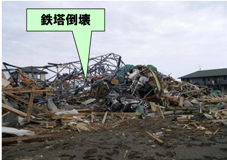
津波・漂流物により鉄塔倒壊、設備収容箱全壊、引込柱全壊 ※地震の揺れによる鉄塔倒壊は無し
