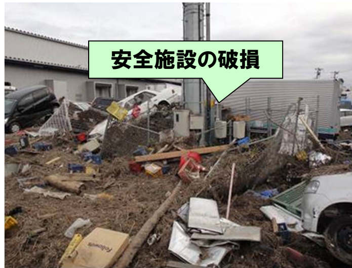
津波・漂流物により鉄塔倒壊、設備収容箱全壊、引込柱全壊 ※地震の揺れによる鉄塔倒壊は無し
