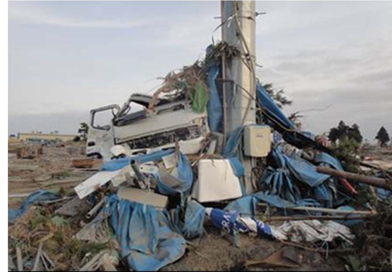
鉄塔は無事、設備収容箱は流された車等の激突により大破 周囲の引込柱も無くなっている状況
