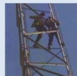
Wi-Fi技術を活用し、ルーラルエリアにおけるインターネット接続環境を提供するテレセンタープロジェクトの作業の様子
