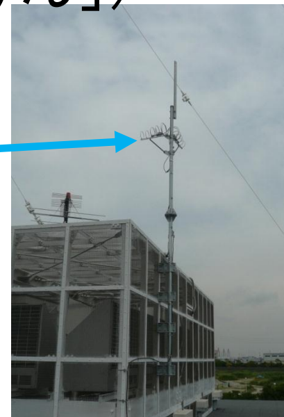
送信アンテナ (1段2面5素子リング)
