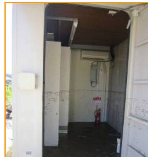
《和歌山県の被災した通信ビル内部》
