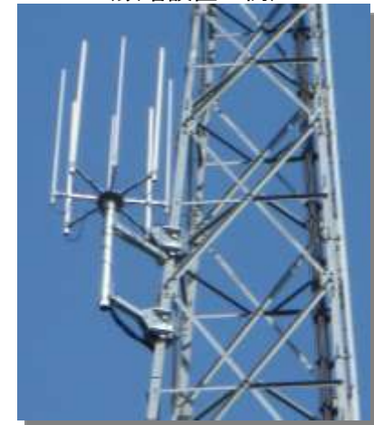
マクロセル基地局 (鉄塔設置の例)
