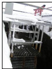
オープンクロスフロー型水車の発電実験
