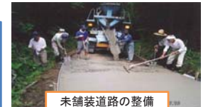
未舗装道路の整備
