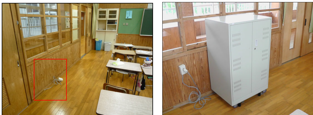
図 4-3 新規電源コンセントの増設状況
