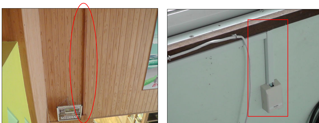
図 5-1 配線設備 (左) 正面玄関吹き抜け(右) 理科準備室
