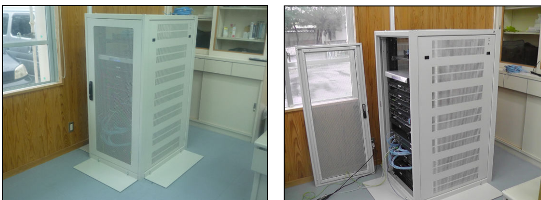
図 5-12 校内サーバー設置状況
