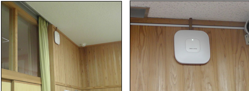
図 4-11 無線LANアクセスポイント設置状況
