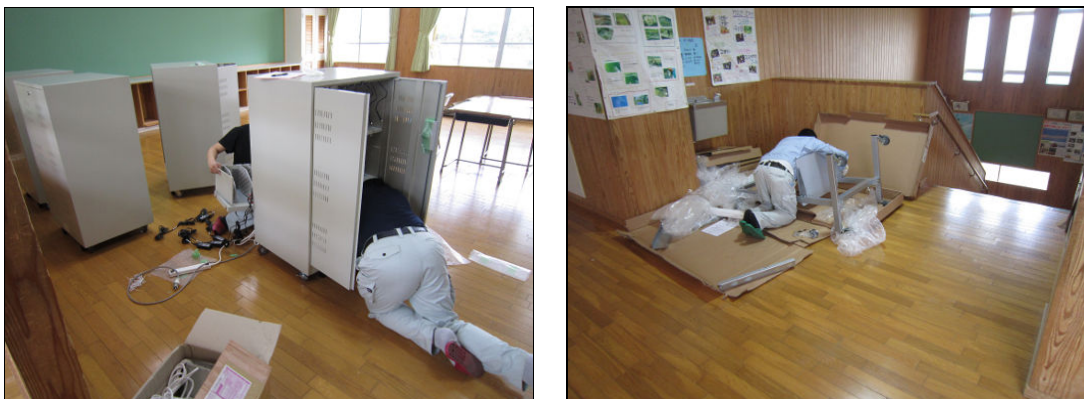
図 5-11 IWB・充電保管庫の組立て作業
