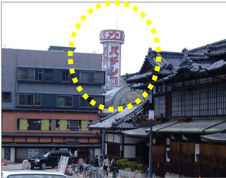
(2) パチンコ丸の内 屋上広告
