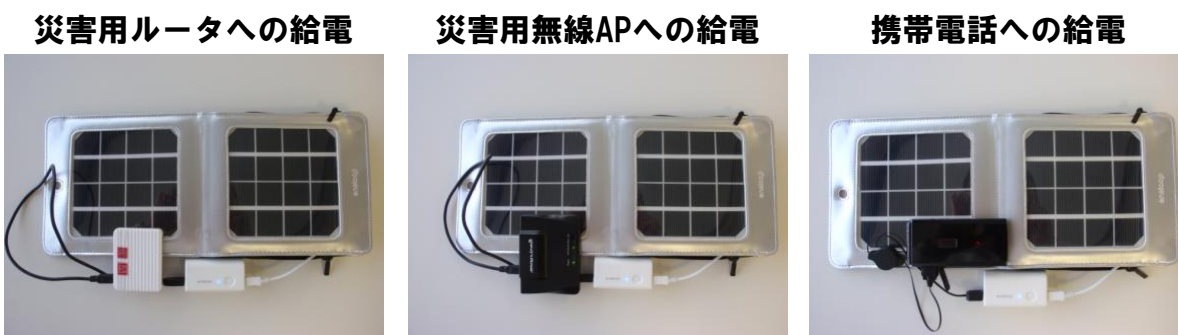
図 124 太陽光パネルからの給電
