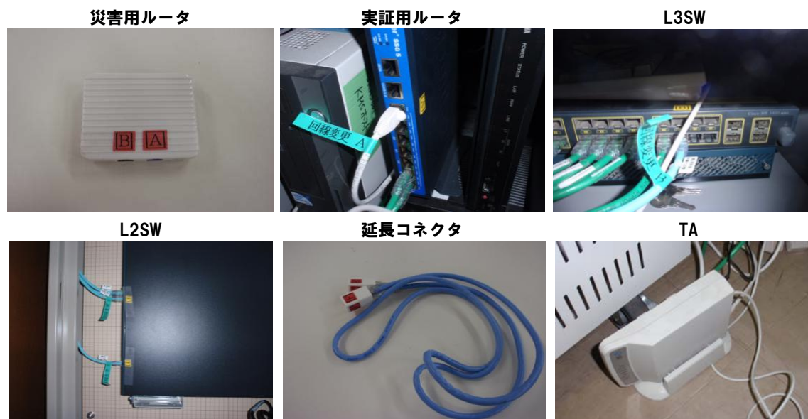
図 117 ネットワーク切替えに必要な機器の切替えラベル
