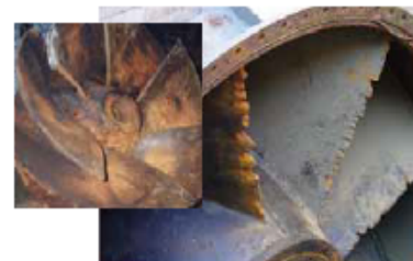
排水機場のポンプ羽根の欠損 (新潟県)
