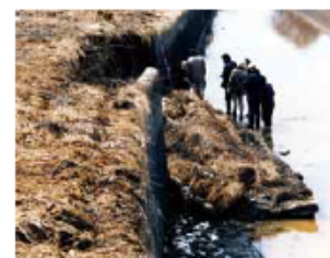
倒壊した幹線用水路の擁壁 (北海道)
