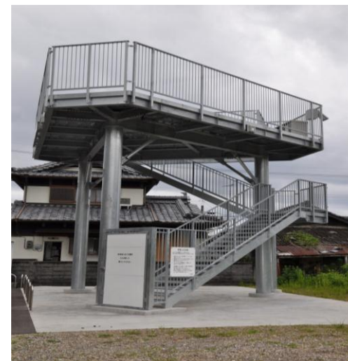
津波避難タワー（防災・減災事業）
