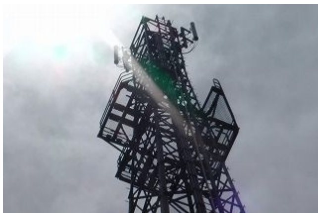
基地局アンテナ
