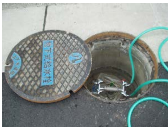
<地下式給水栓>
