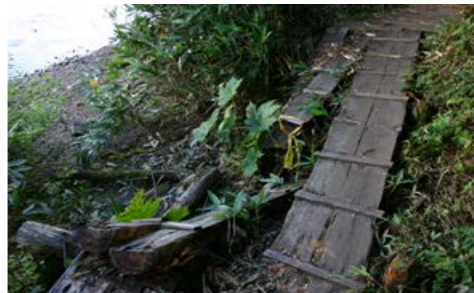
破損している木道(尾瀬沼南岸線歩道)
