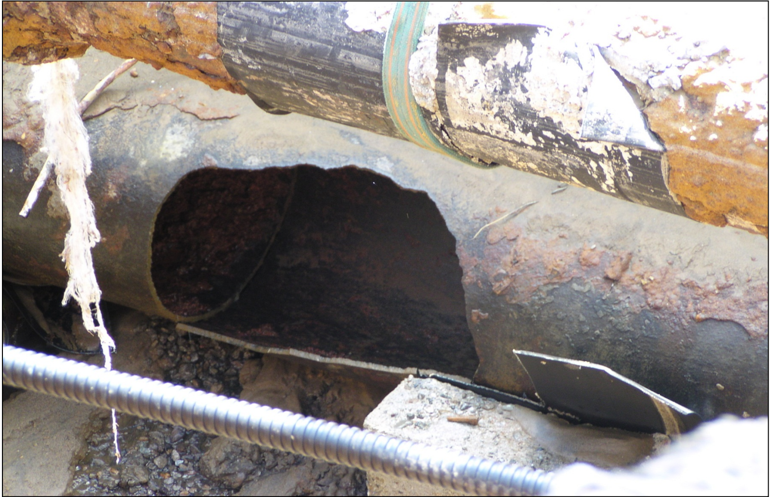
漏水事故管 (F C \phi 500mm)
