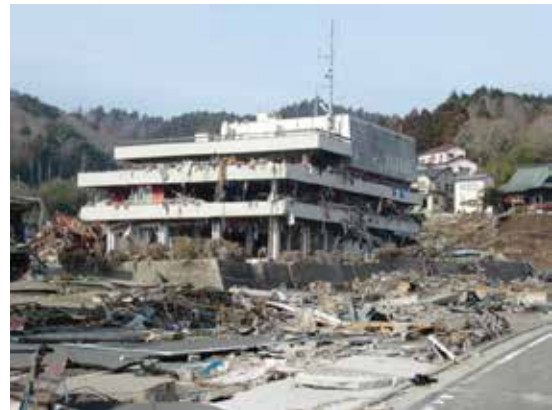
【女川町役場庁舎の被害状況】
