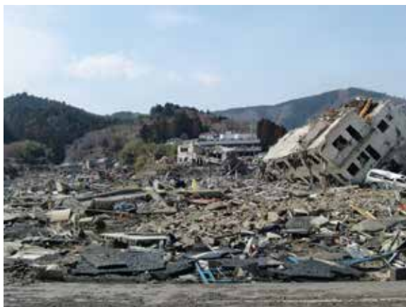
【女川町内の家屋の被害状況】
