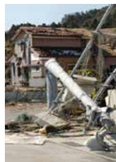
【防災行政無線（屋外拡声器）の被害状況】
