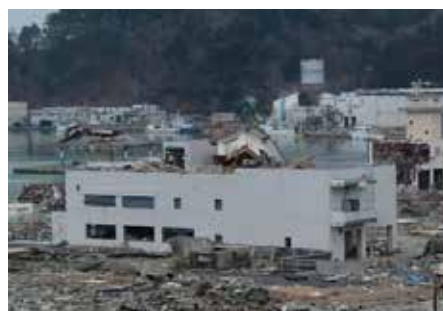
【NTT 通信ビル被害状況】
