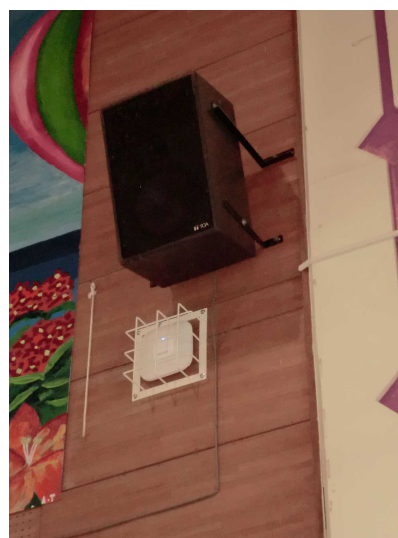
図 4-4 体育館における無線LANアクセスポイント設置状況
