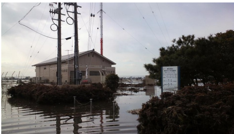
津波による被害を受けた東北放送荒井ラジオ送信所（海岸部から約2.4km、海拔約2m）
