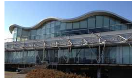
メインオフィス外観
