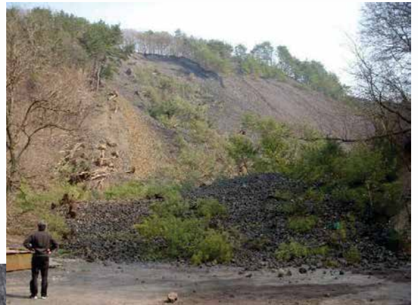
3月13日、がけ崩れで通行止の道を迂回しての燃料補給
