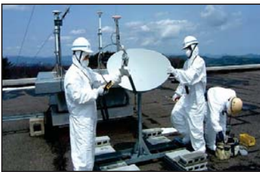
福島第一原子力発電所事故に伴う避難指示区域内での工事
