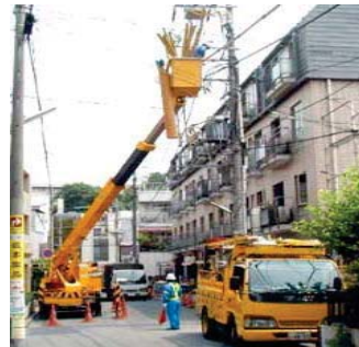
市街地での配電線保守 (デジタル 400MHz移動無線)
