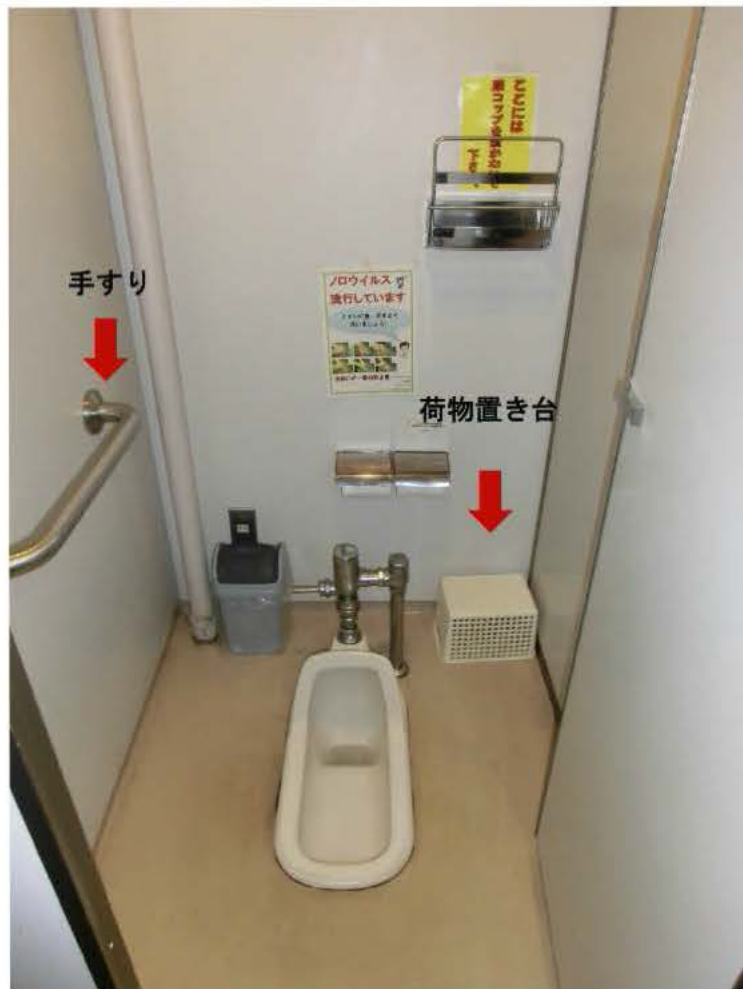
③ 手すり、荷物置き台などが設置されている和式トイレの例 (山形市内の病院)
