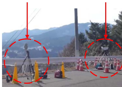
図 3.9.7 無線伝送設備 発電機で運転（安波山駐車場）
