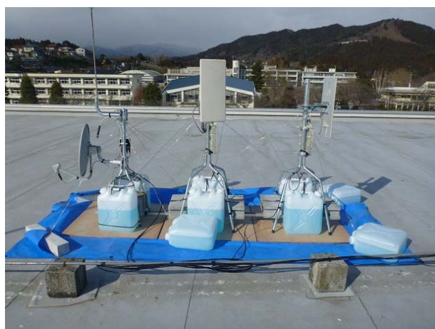
送受信アンテナ設備
