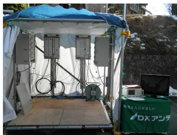
可搬型緊急用ヘッドエンド設備設置
