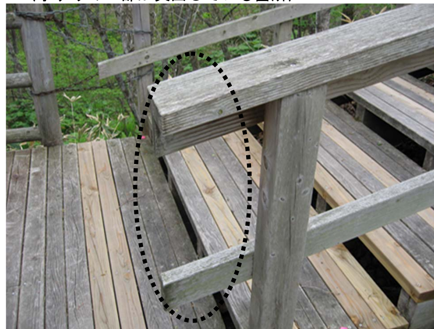
〈手すりの一部が突出している箇所〉
