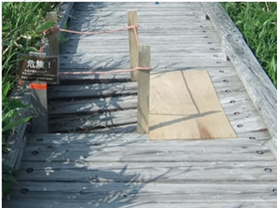
〈損傷箇所の例〉
