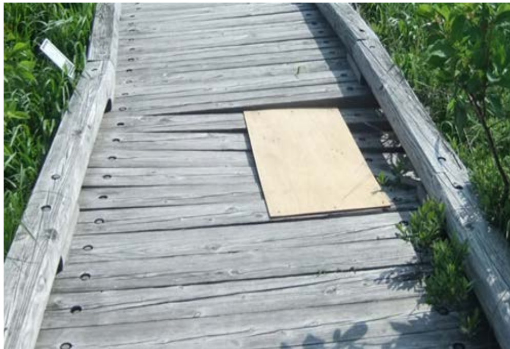
写真2 木道の一部が損傷している箇所为例
