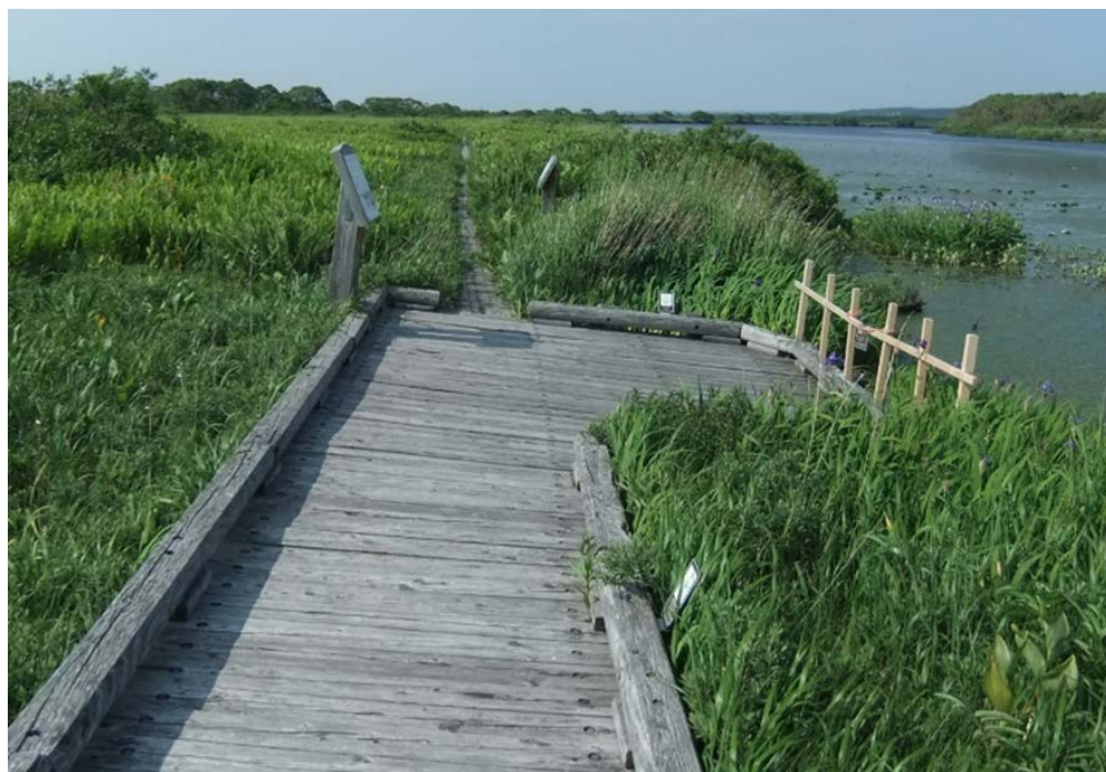
写真3 木道が沼に向かって傾斜している箇所为例
